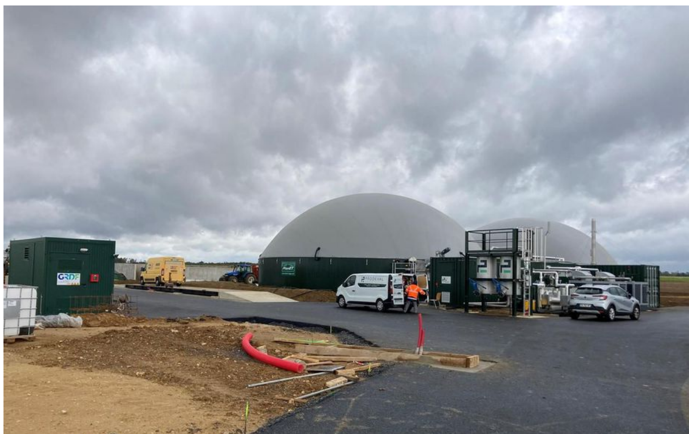
Lévignen. Près de 40 méthaniseurs sont en cours de construction ou à l'étude dans le département. LP/C.B.
